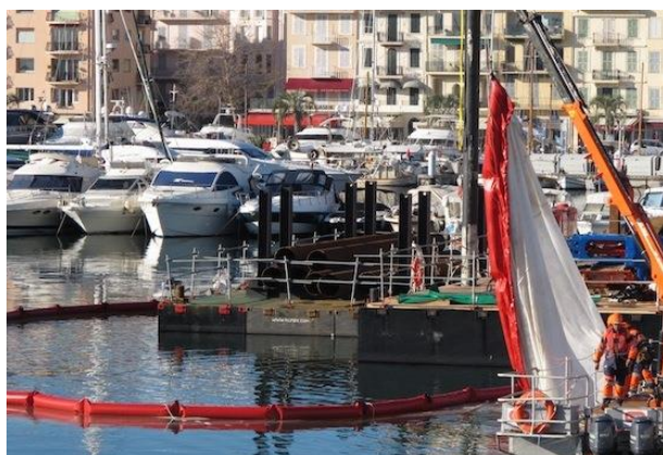
Mise en place barrage-barrière filtrant MES pour travaux maritimes BTM- port de CANNES
